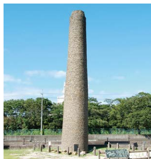
三田尻塩田旧越中屋金屋煙突
